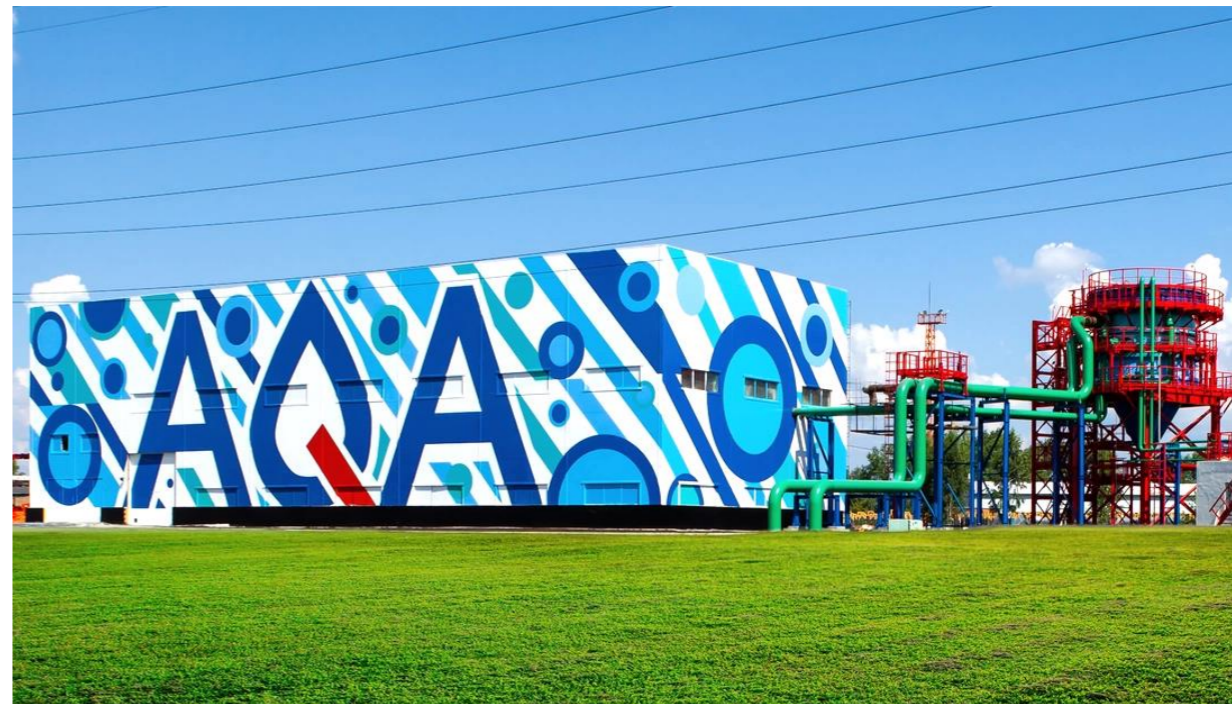
➤ Комплекс очистных сооружений «АQA Генезис», АО «Первоуральский новотрубный завод»
